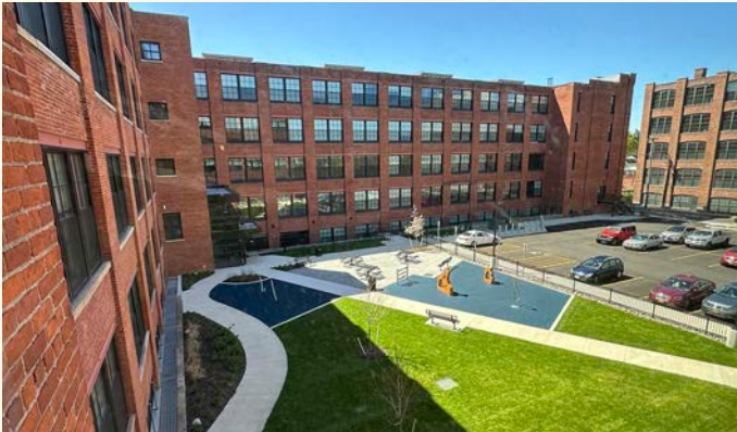
Canal Commons View Playground
